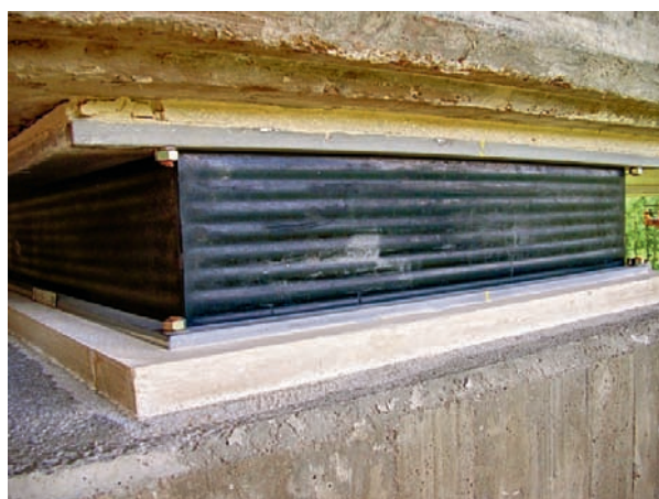
Rys. 17. łożysko elastomerowe dużej nośności (ponad 10 MN) po wbudowaniu (fot. ze zbioru autora)
